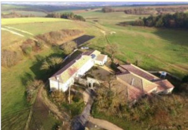
Photographie aérienne des écuries de Chantemerle
