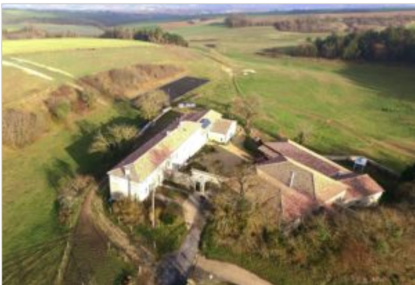
Photographie aérienne des écuries de Chantemerle
